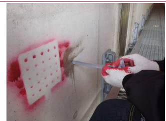
탄산화 깊이 측정
